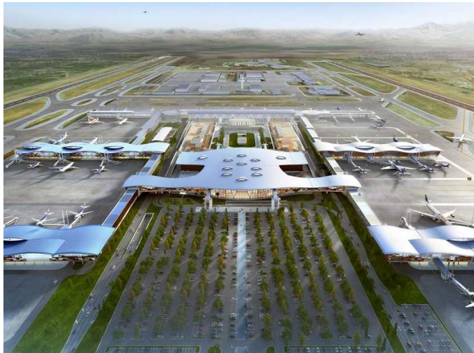
Aeropuerto internacional Arturo Merino Benítez (iniciado en 2015), Santiago de Chile. Luis Vidal + Arquitectos-ADP Ingénierie. Imagen: LVA
