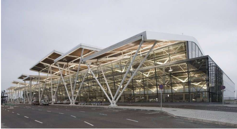
Terminal del aeropuerto de Zaragoza, LVA Luis Vidal + Arquitectos. Imagen: Miguel de Guzmán
