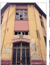
Una de sus fachadas en el barrio Mata Sur.
